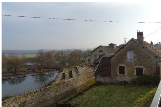
Ancienne papeterie, Savoyeux – un site pittoresque à forte valeur patrimoniale peu valorisé (présence de décharge, pas d'accès, abandon du bâti)
