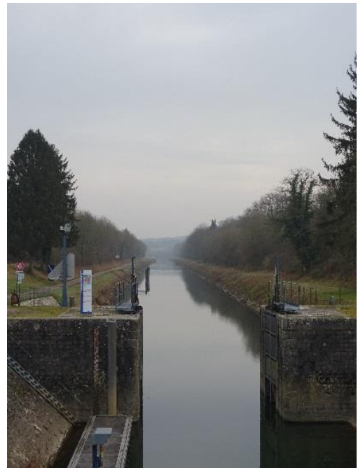
Cours d'eau canalisé à Ferrières-lès-Ray
