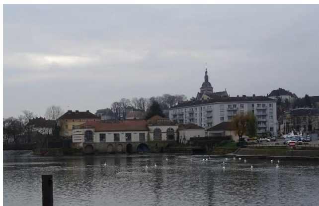
Ancien Moulin à farine dit moulin Tramoy, puis minoterie des Grands Moulins de Gray, actuellement centrale hydroélectrique, Gray
