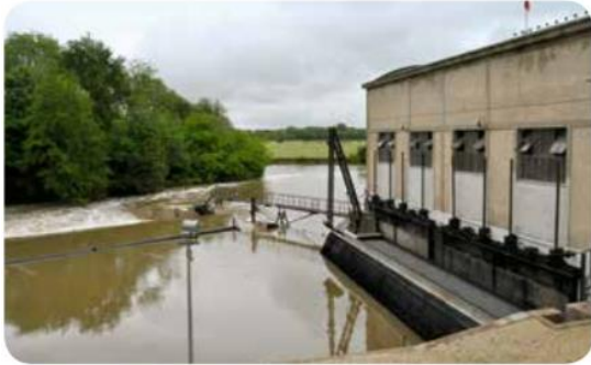
▷ Vue d'ensemble de la centrale après travaux
