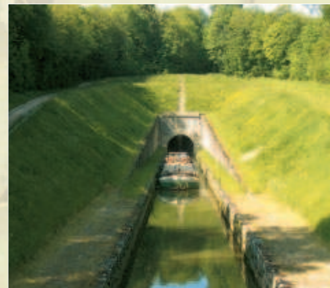
Tunnel de Savoieux.
